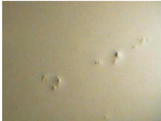
Particelle estranee inglobate nel film di vernice
